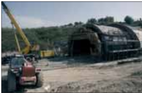
Un'immagine dei lavori sulla A3
